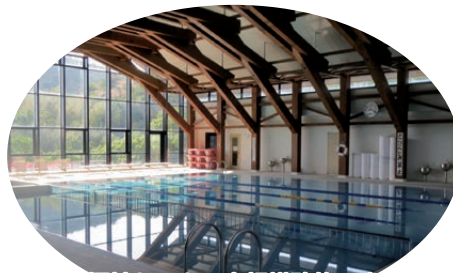
福祉センター大規模改修工事
