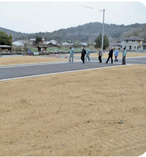
完成した積浦造成地
