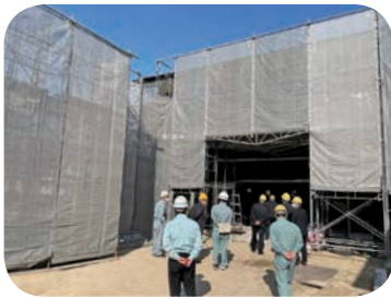
建設現場を視察
