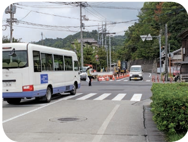
無電柱化工事（住吉神社付近）
