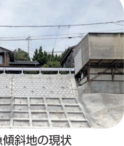
横防急傾斜地の現状
