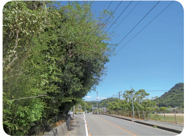
道路にはみ出し危険
